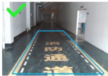
车间消防通道
