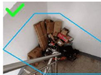
楼道消防通道
