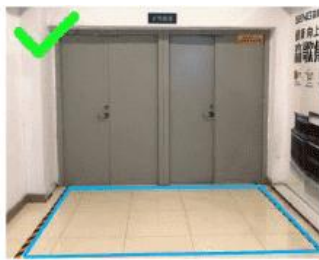
商场消防通道
